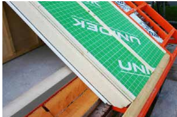
Figuur 3 Doorlopende isolatieschil: spouwmuurisolatie sluit direct aan op dakisolatie Unidek Aero Passief
